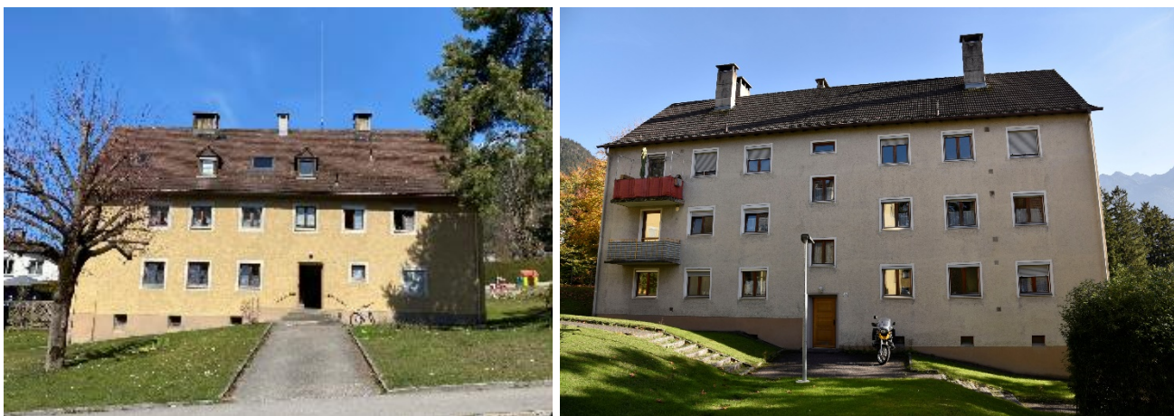
Abbildung 1: Gebäudetyp klein (links, Foto EIV) und groß (rechts, Foto M. Fortenbacher)
