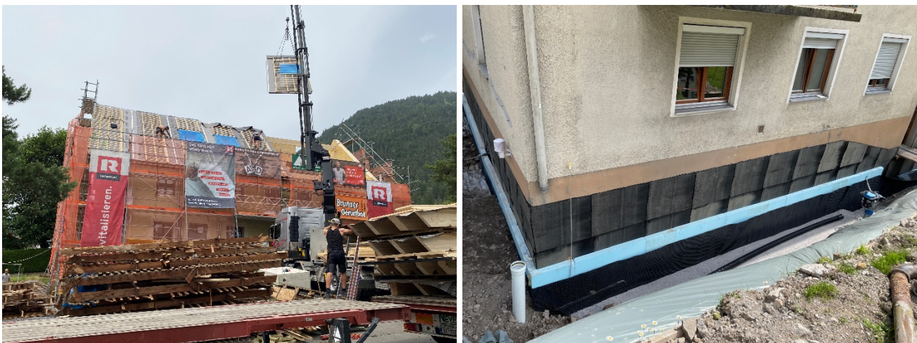
Abbildung 3: Montage der vorgefertigten Dachelemente, Abdichtung und Außendämmung Keller
